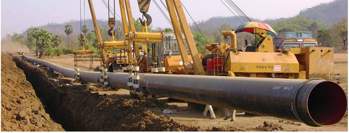
पाइपलाइन बिछाने का कार्य
