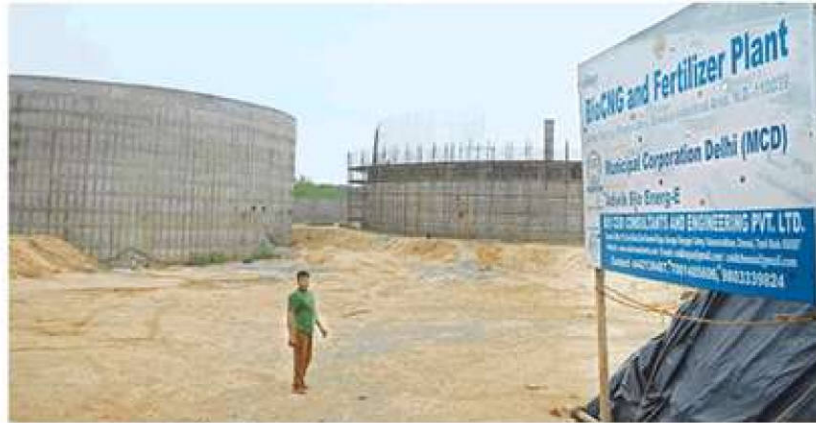
घोघा गांव में निर्माणाधीन गोबर गैस प्लांट • जागरण
